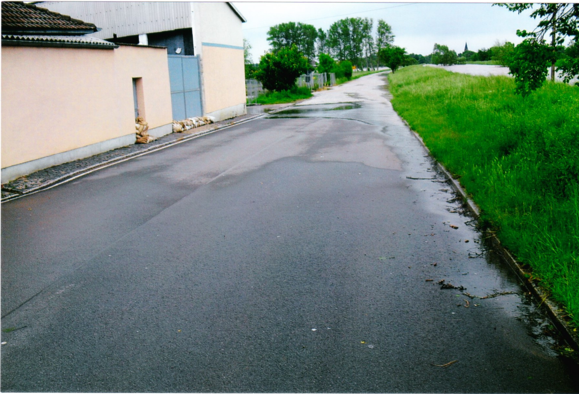
Die Straße nach Ringleben wird überflutet
